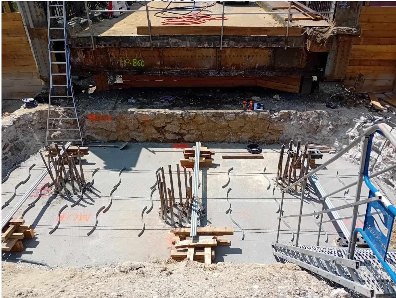
Travaux sur culée
