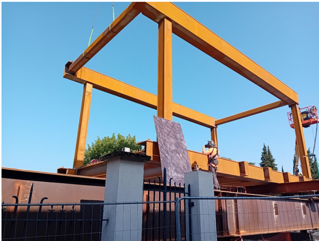
Début de l'assemblage de la structure
