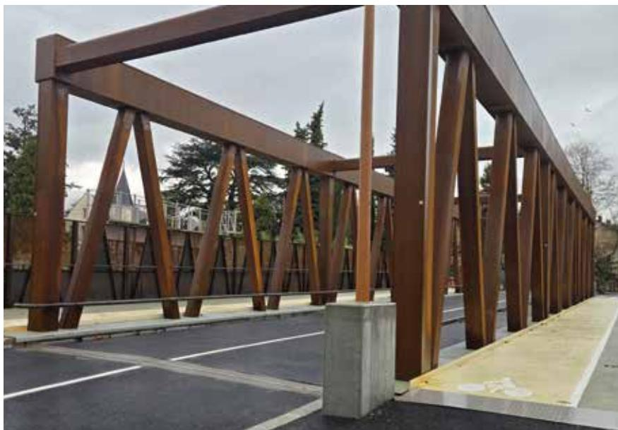
Ce nouvel équipement, réalisé en acier corten durable, conserve un aspect industriel et **s'intègre harmonieusement dans le cadre urbain**. Son architecture est plus généreuse que l'ancienne structure centenaire, qui a dû être remplacée en raison de son état de corrosion avancé. La résistance du nouveau pont a été confirmée par différentes épreuves de charge.
